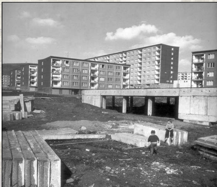
1975. Výstavba nákupního střediska na sídlišti Petlerská ...
