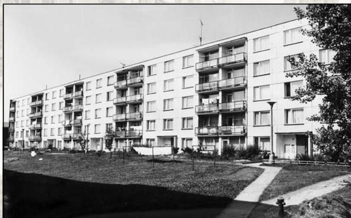
Snímek domu v ulici Golovinova 1326 – 1330 v Kadaně patřícího elektrárenskému družstvu byl pořízen v první polovině sedmdesátých let.
