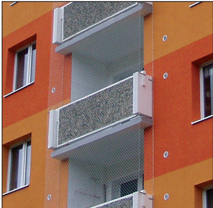
Zasíťované lodžie v Dlouhé 532-533.
